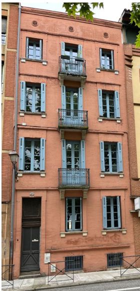
Façade Quai de Tounis
