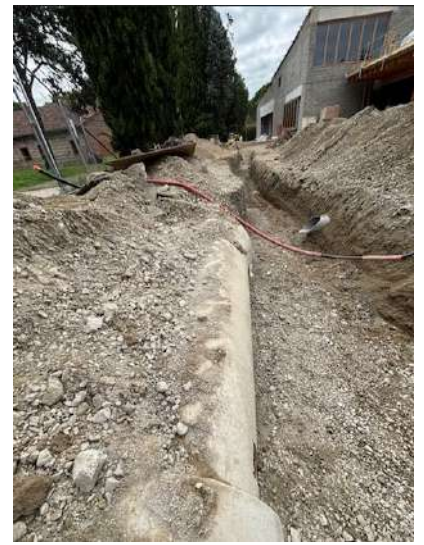
Tranchée entre bâtiments neuf et existants
