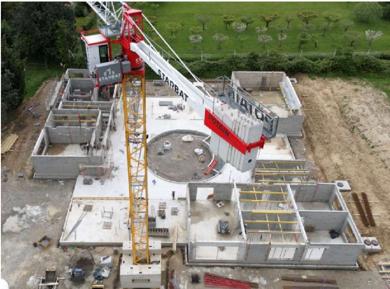
Début des élévations maçonnières
