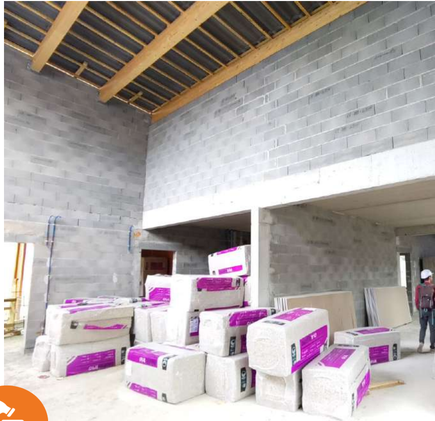
Isolation par l'intérieur biosourcé (biofib)
