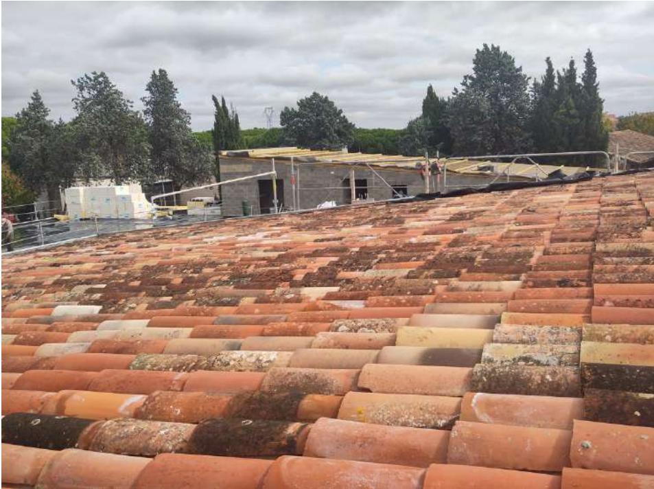
Pose des tuiles de réemploi
