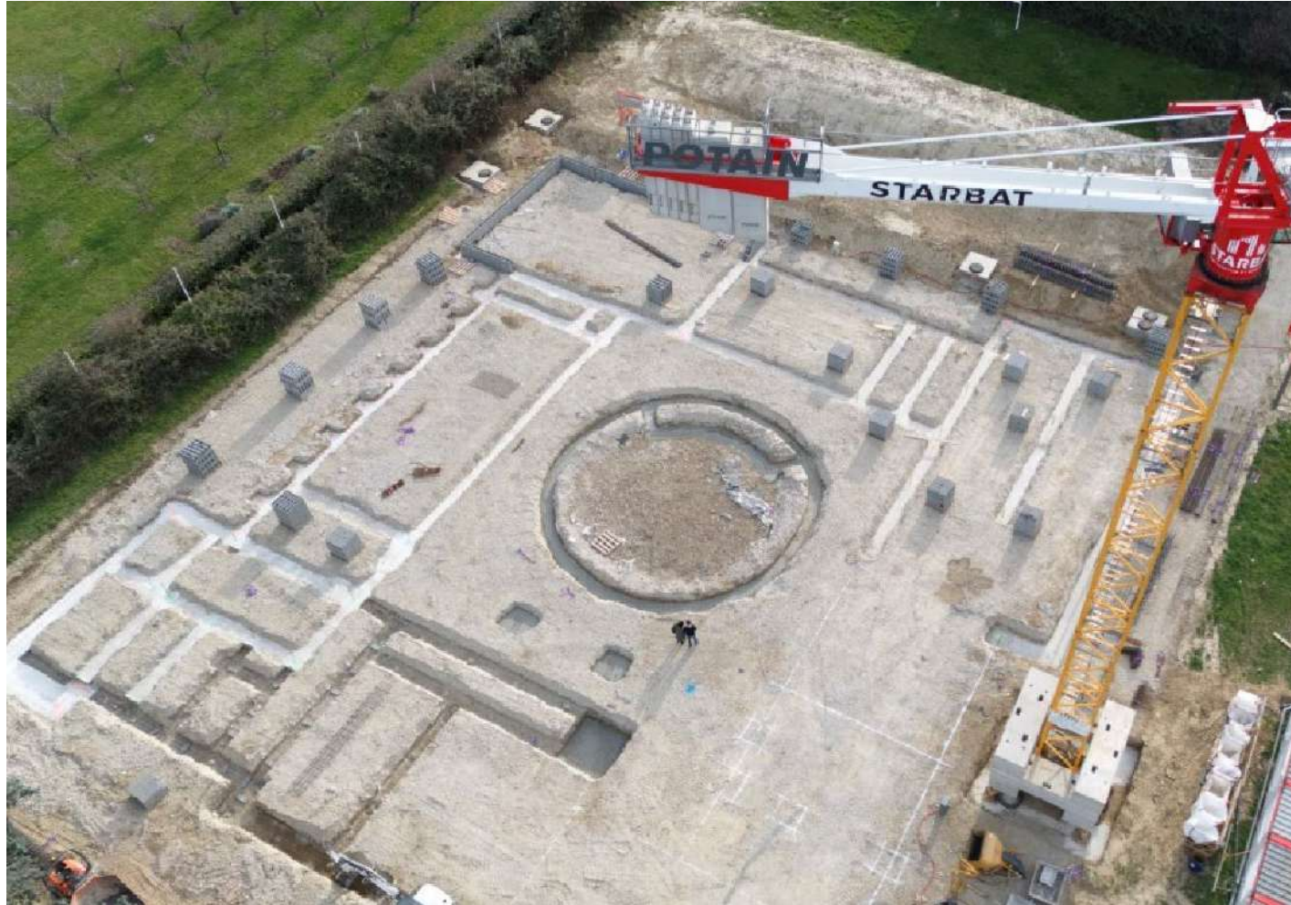
Coulage et ferrillage des fondations
