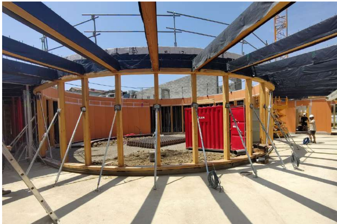
Charpente et murs à ossature bois
