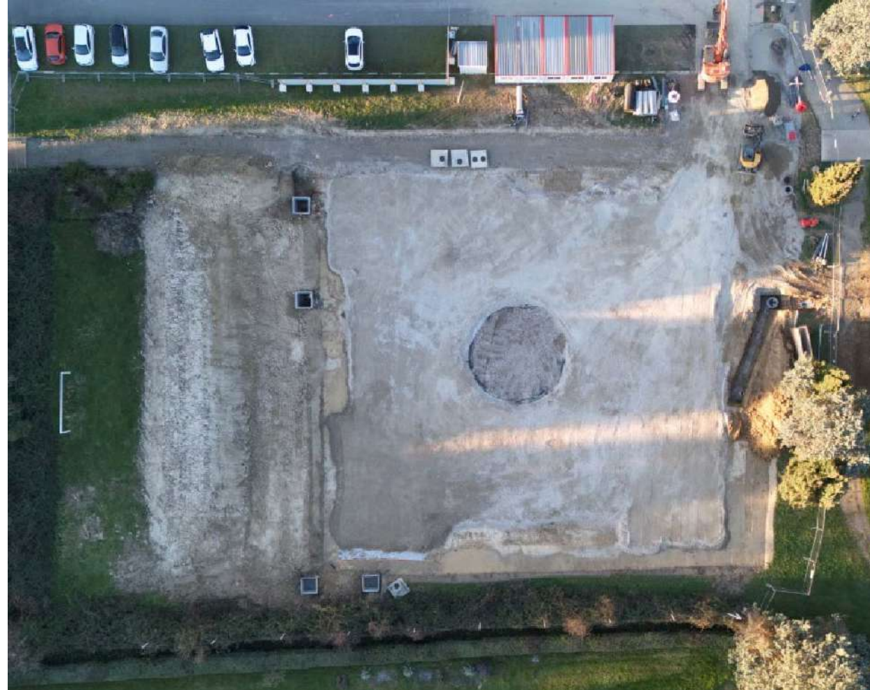
Terrassement du terrain
