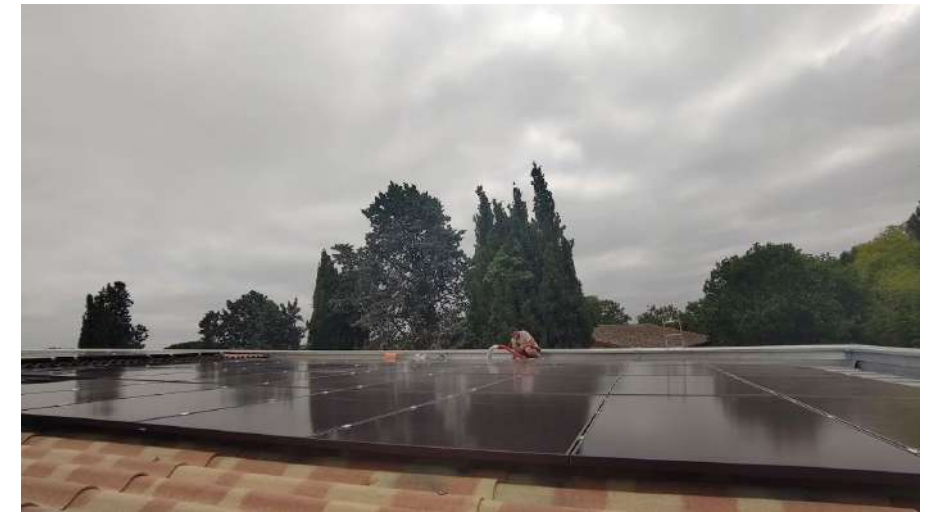
Installation PV en toiture Sud
