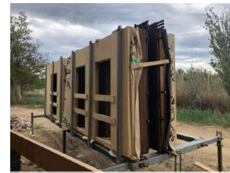
Murs préfabriqués en attente
