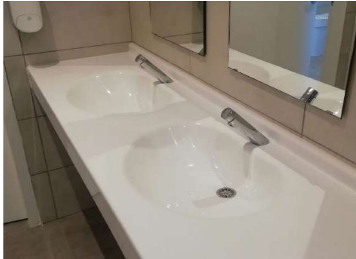
Robinet thermostatique temporisé
