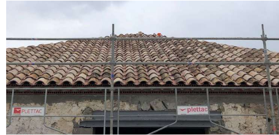
Réemploi des tuiles en bon état
