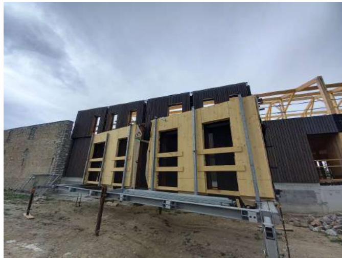
Murs préfabriqués en attente
