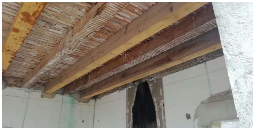
Reprise structure bois plancher intermédiaire
