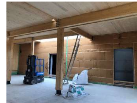
Mise en place de l'isolant en fibre de bois
