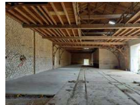
Nettoyage RDC - Hangar
