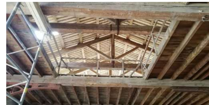
Rénovation charpente hangar
