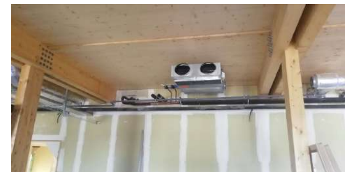
Pose des UTA
