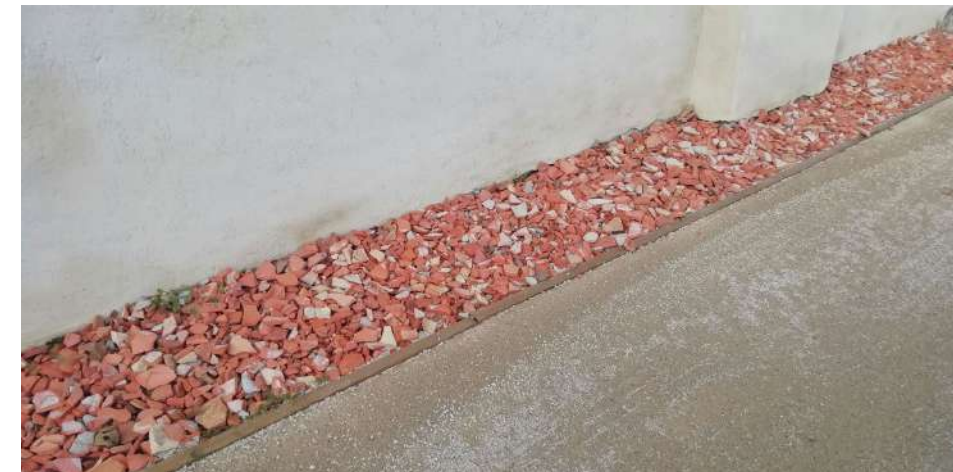
Concassage d'une partie des tuiles abimées
