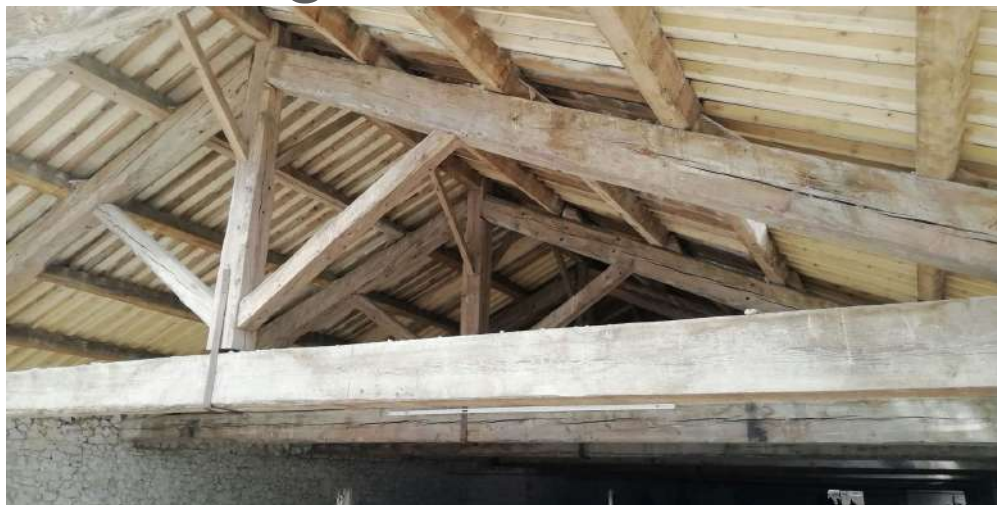
Rénovation charpente Halle
