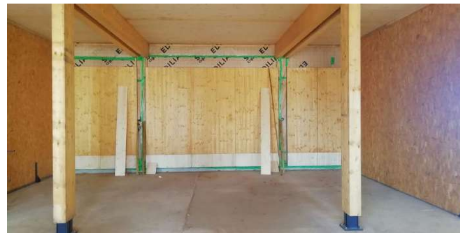
Propreté de chantier intérieur
