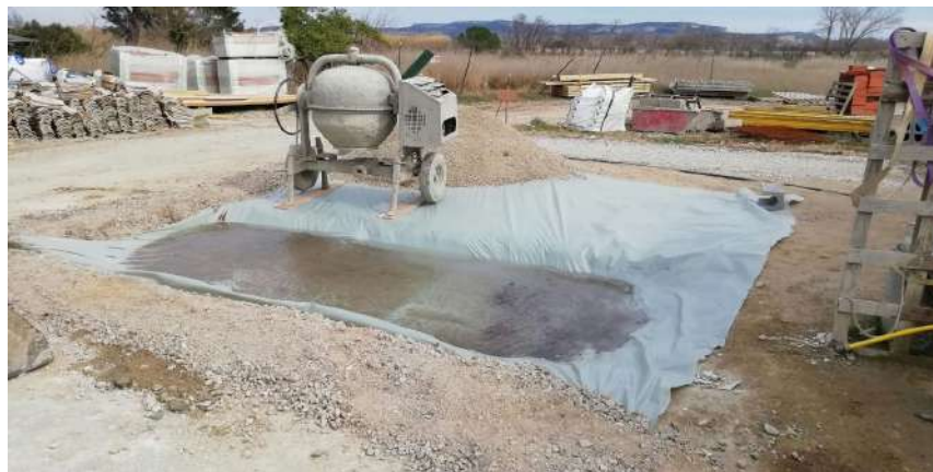
Zone de décantation des eaux de lavages du béton
