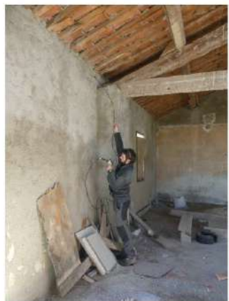
Vérification d'une anfractuosit      l'aide d'un endoscope C  line Lesot (ARTIFEX), 18-11-2021
