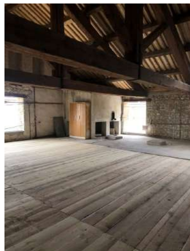
Reprise plancher intermédiaire - Hangar
