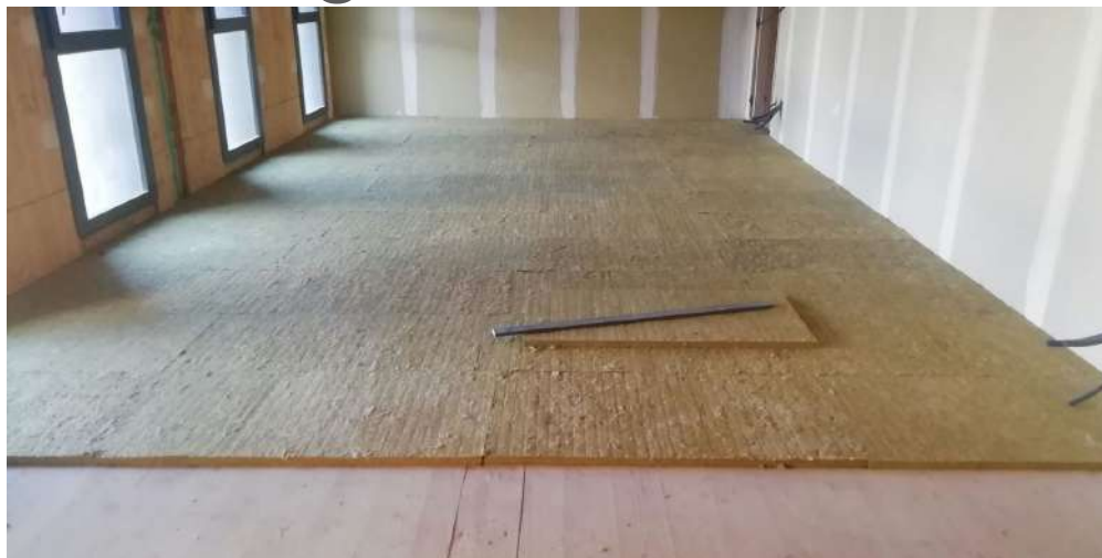
Sous-couche acoustique en laine de roche
