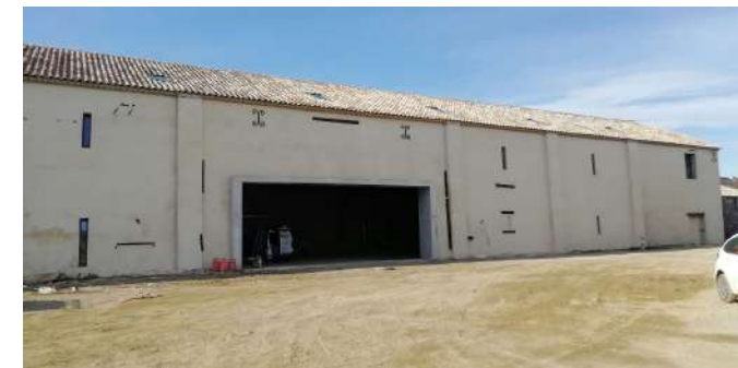
Vue hangar Est
