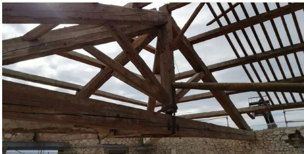
Rénovation charpente hangar
