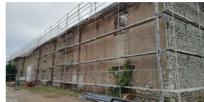
Echafaudage murs extérieurs du Hangar
