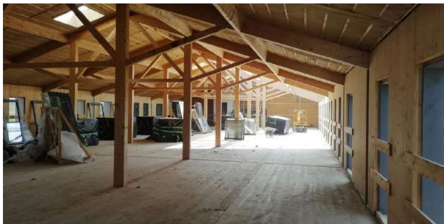
Propreté de chantier intérieur
