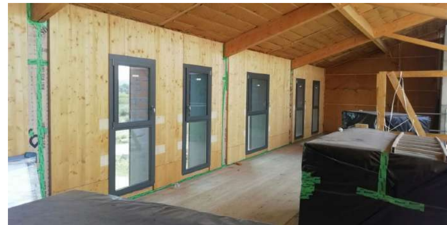
Propreté de chantier intérieur
