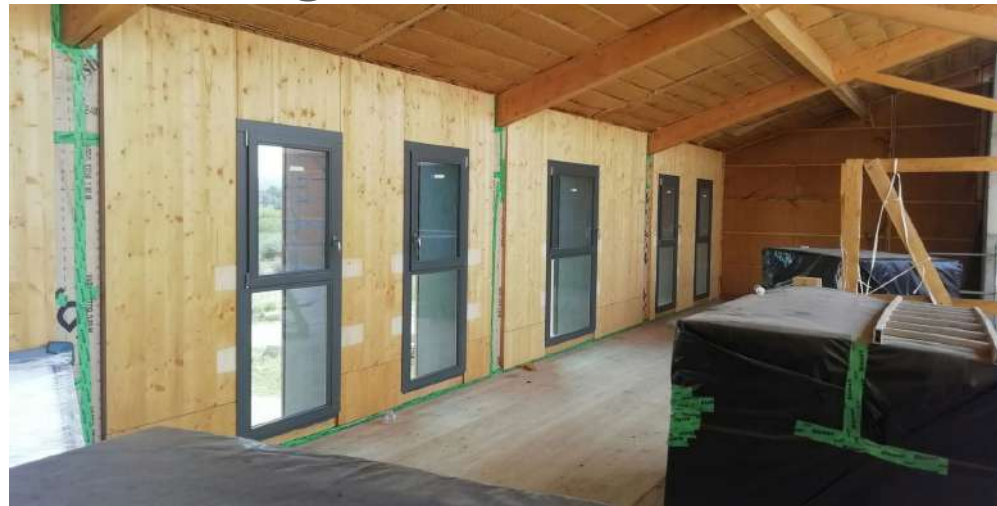
Pose des menuiseries – Bureaux PNR neuf
