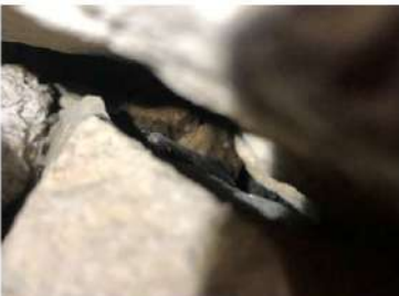
S  rotine commune en hibernation dans le mur du chai C  line Lesot (ARTIFEX), 18-11-2021
