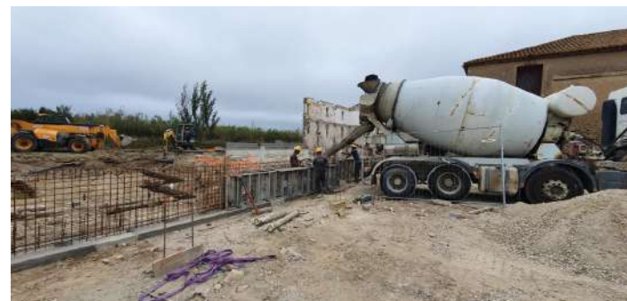
Coulage murs de soubassement
