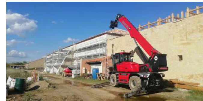
Traitement façade hangar coté Sud-Ouest
