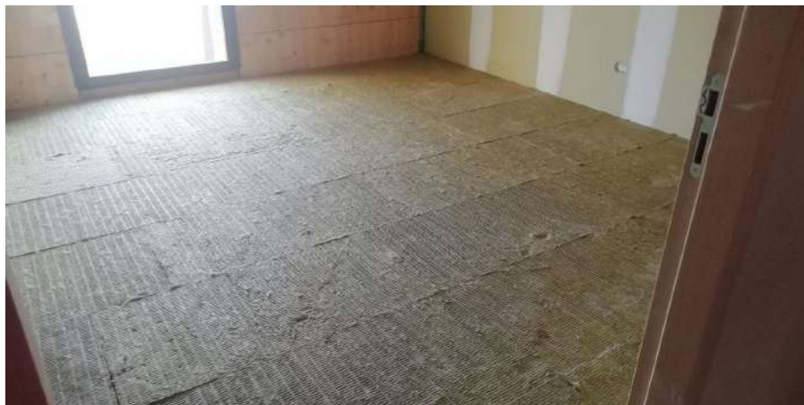
Propreté de chantier intérieur
