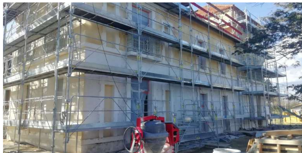
Traitement Vue Sud ouest
