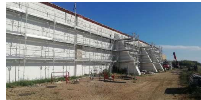
Traitement façade hangar coté Nord-Ouest
