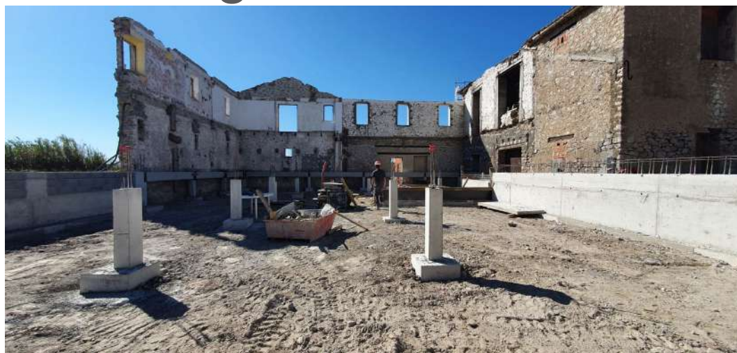
Fondations bâtiment neuf
