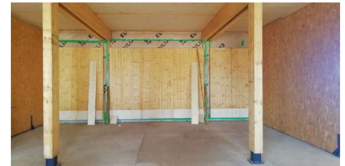
Traitement de l'étanchéité à l'air – Bureaux PNR neuf
