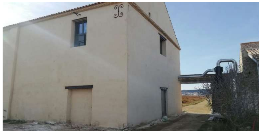
Vue hangar Nord
