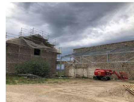
Mise en place de la charpente métallique
