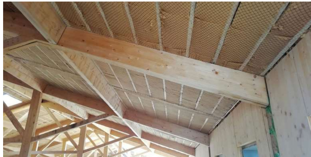
Pose isolation toiture – Bureaux PNR neuf
