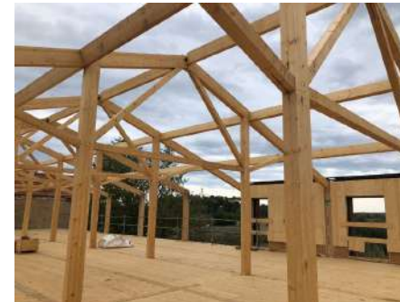
Charpente bâtiment neuf
