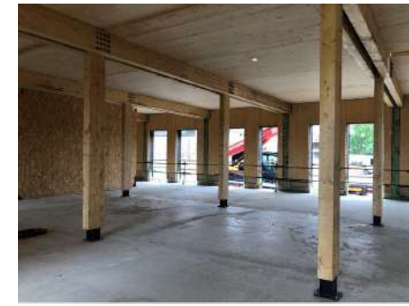
RDC bâtiment neuf
