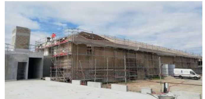
Echafaudage murs extérieurs du Hangar
