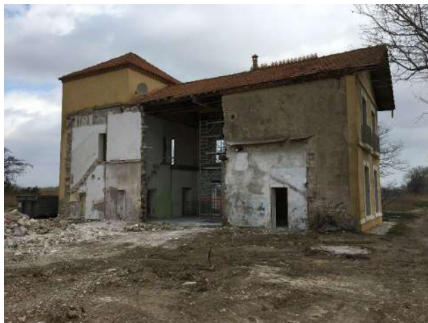
Structure conservée - Bureaux PNR rénovés
