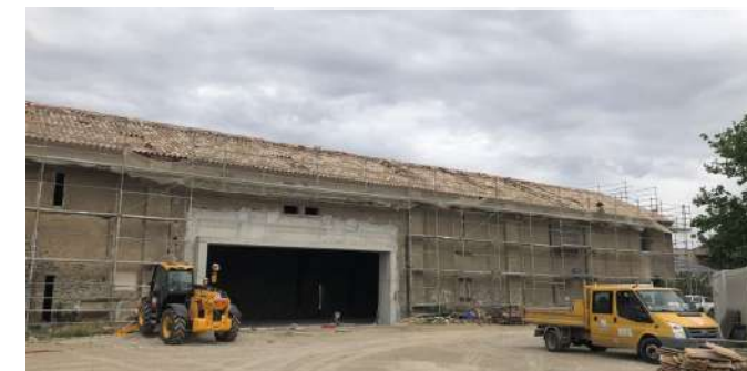
Réalisation du seuil de l'entrée principale - Hangar
