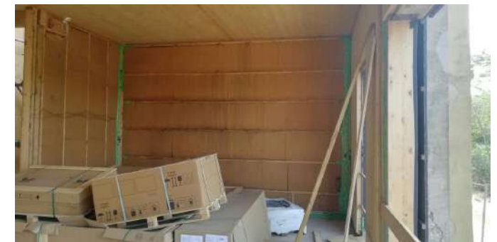
Pose isolation des murs non préfabriqués
