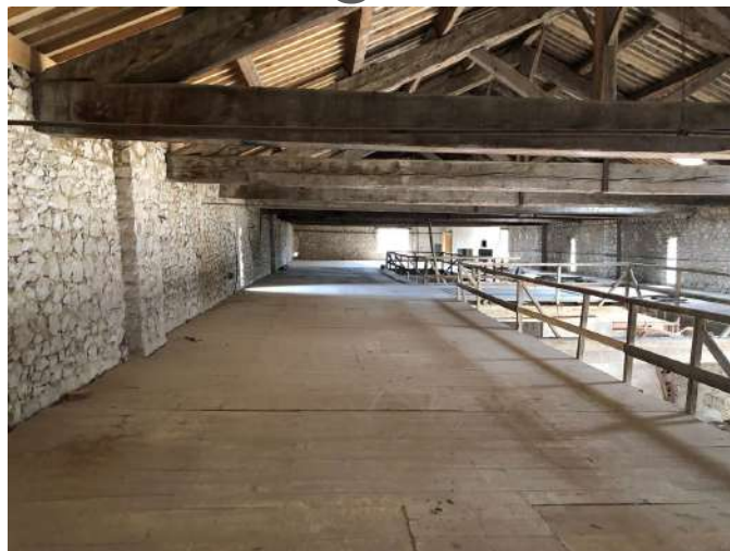
Reprise du plancher intermédiaire - Hangar
