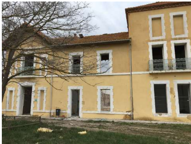
Structure conservée – Bureaux PNR rénovés
