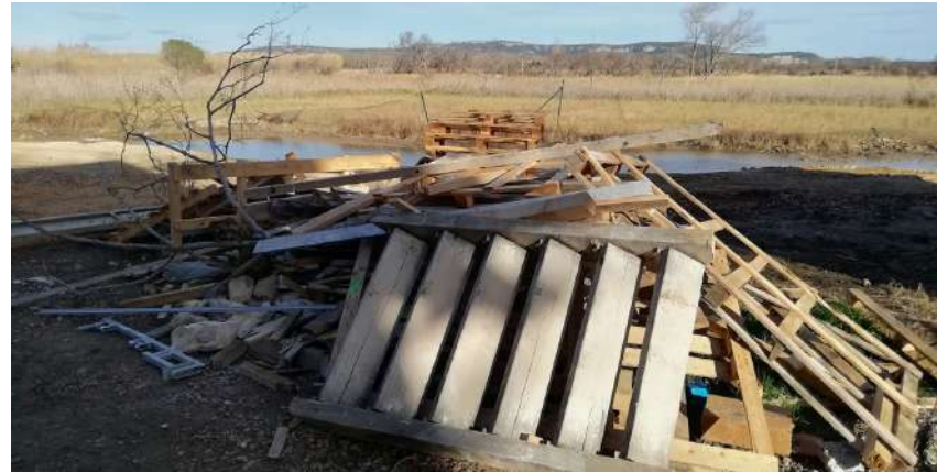
Problématique de propreté de chantier extérieur
