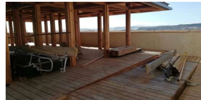
Pose terrasse en bois
