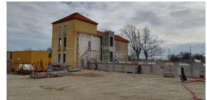
Mise en place de la cage d'escalier
