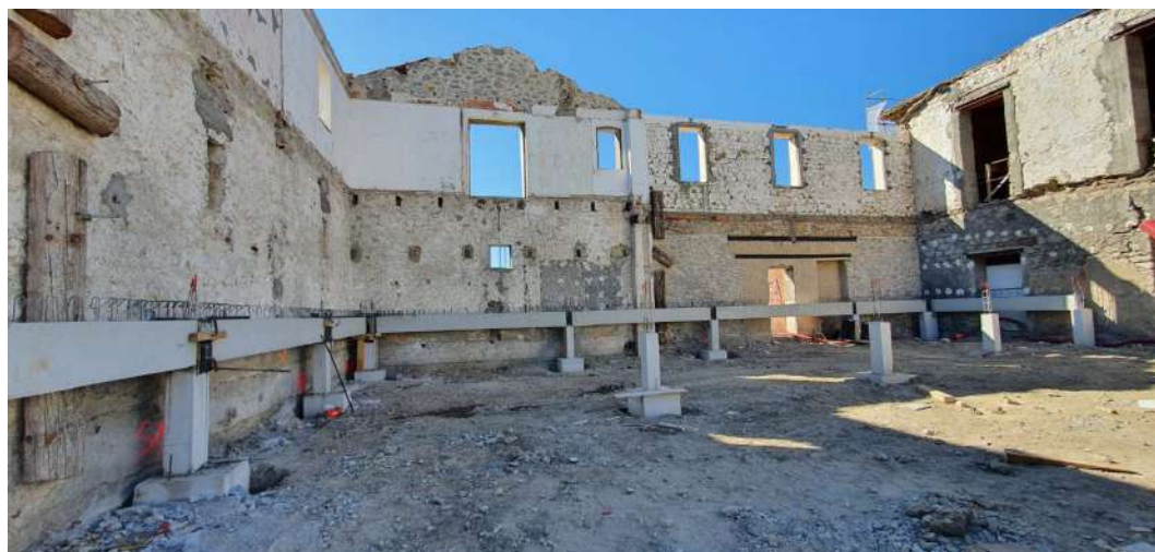
Structure bâtiment rénové
