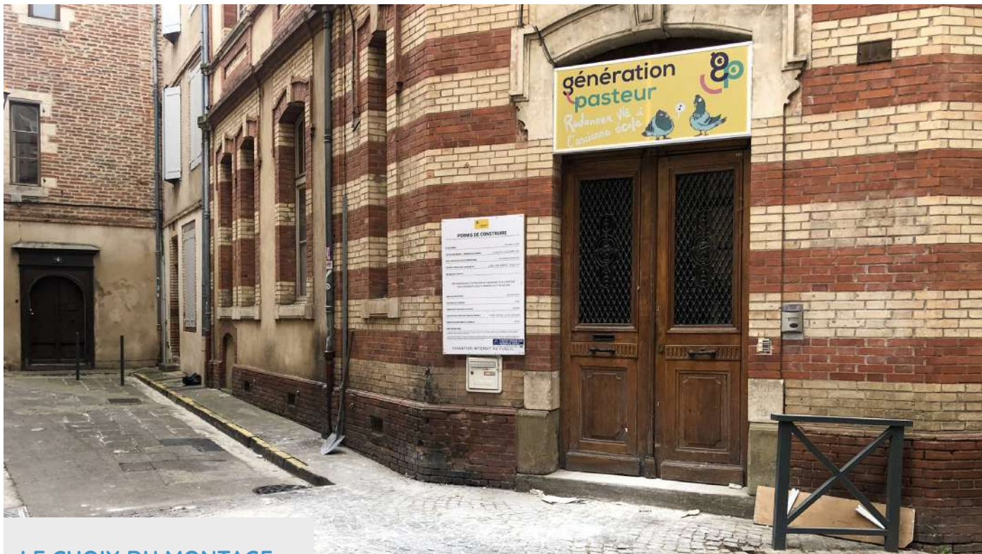
L'entrée de l'ancienne école lors du démarrage du chantier. - Photo : Atelier Arpent
