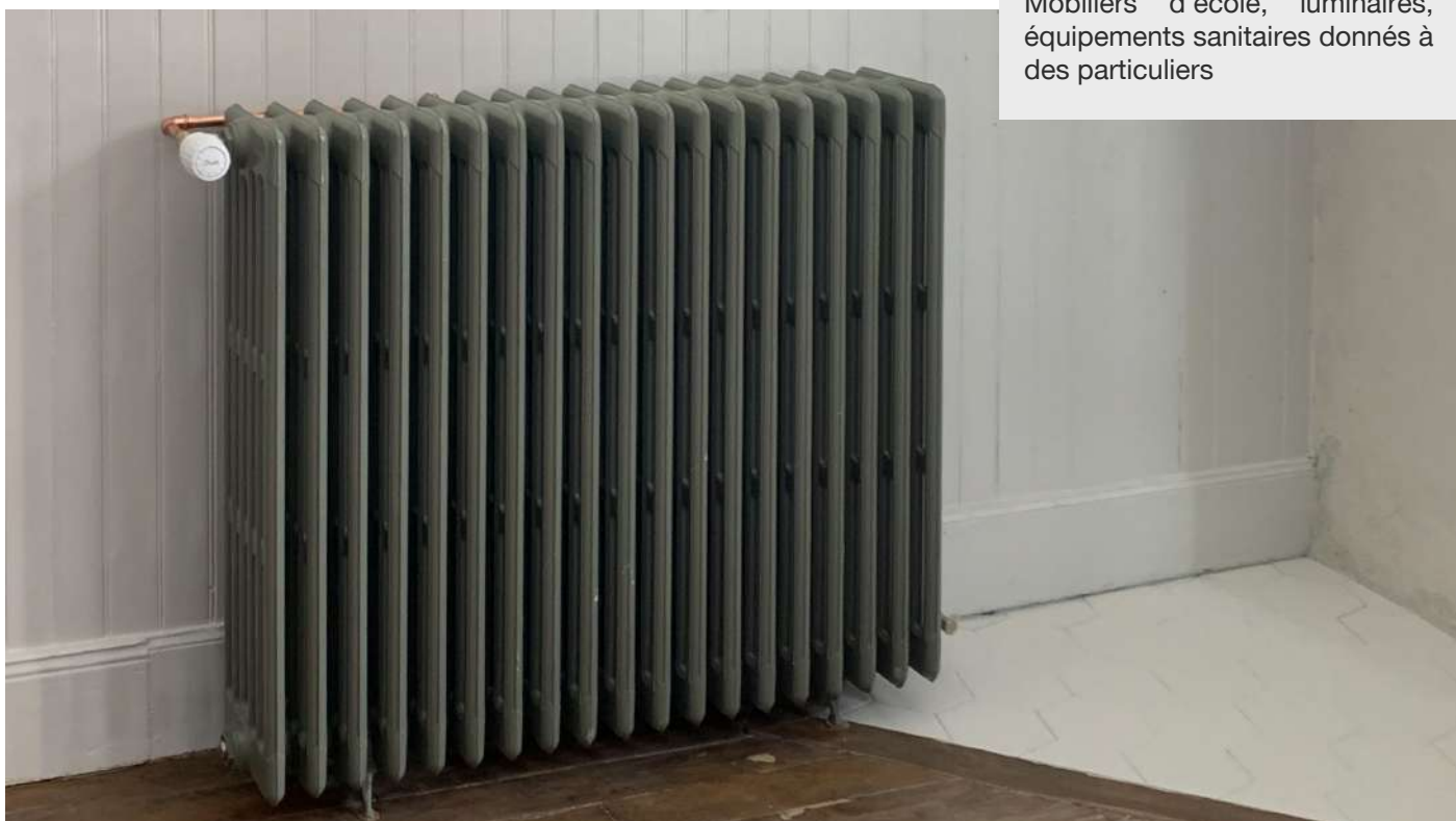
Radiateur en fonte réemployé après sa remise en état. Le parquet existant a été revitrifié. - Photo : Envirobat Occitanie
