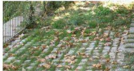
Principe de dalles engazonnées
