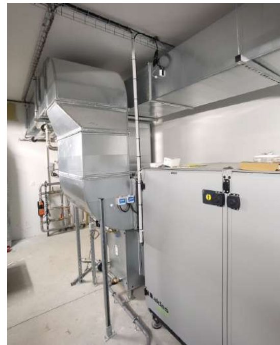
CTA double flux dans local technique dédié
