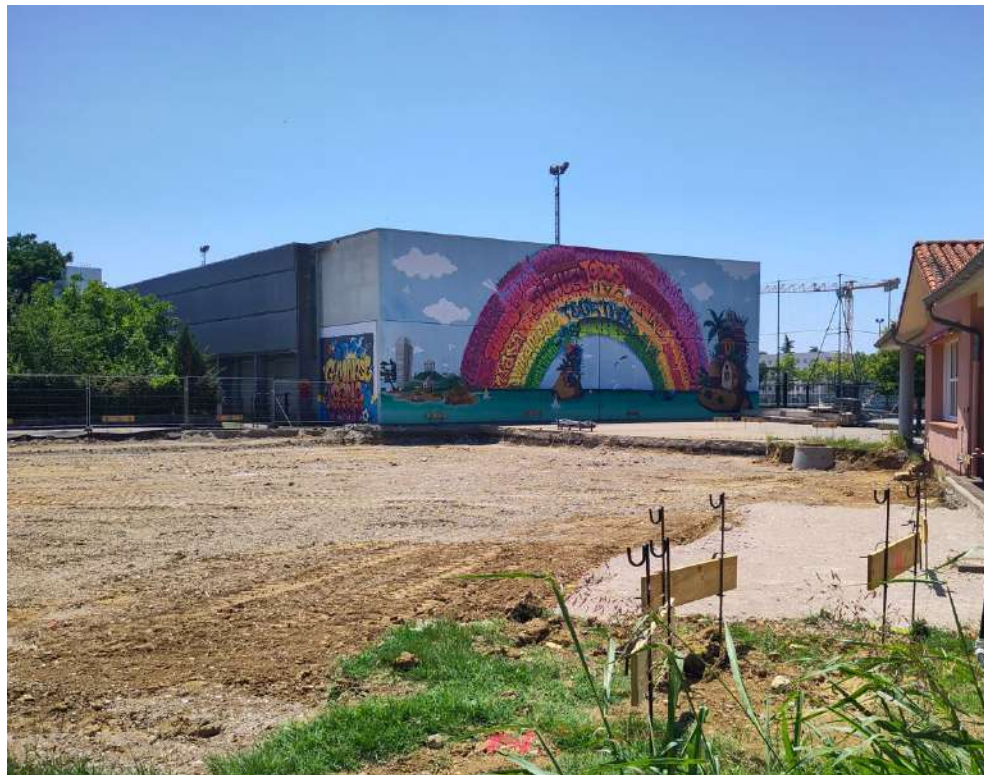
Terrassement du terrain
