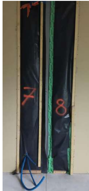
Finition intérieure et jonction modules
