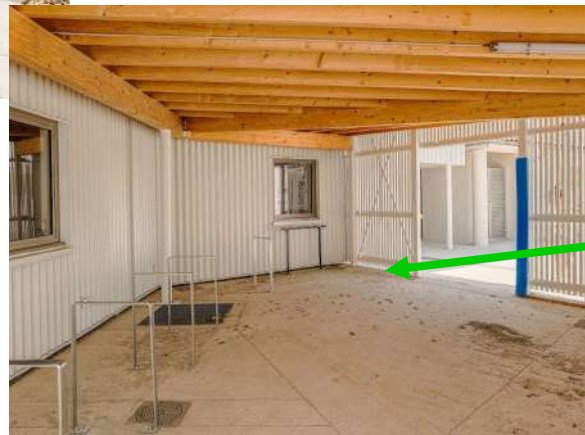
Arceaux vélos et trotinette sur parvis
