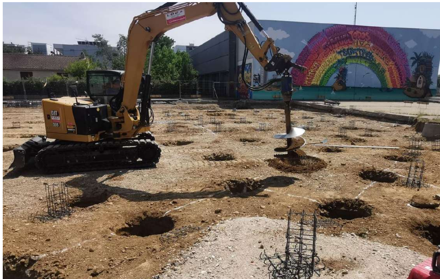
Démarrage des fondations
