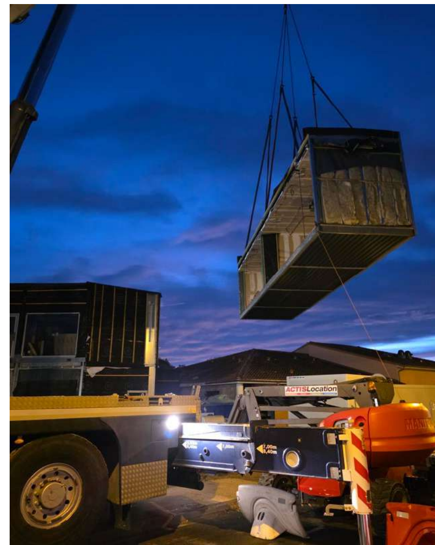
Levage des modules sur site
