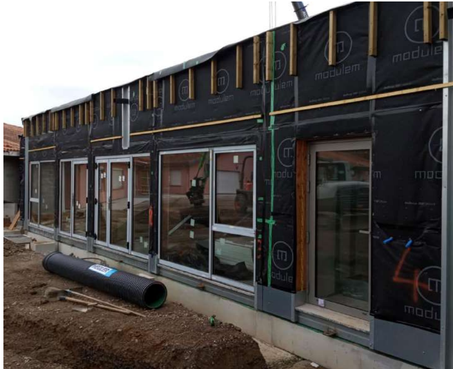
Finition extérieure modules
