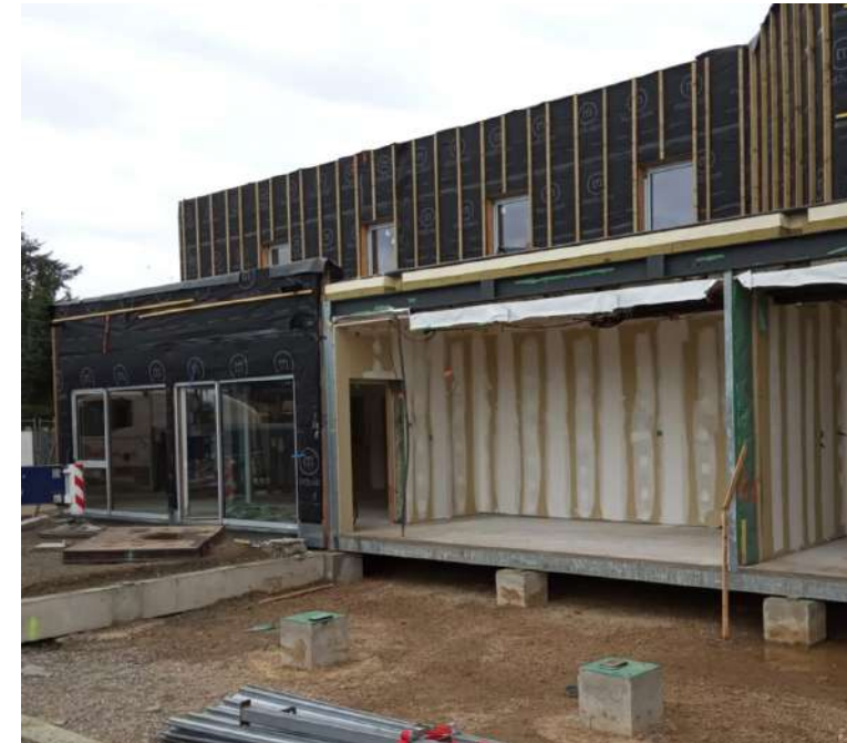
Finition intérieure et jonction modules
