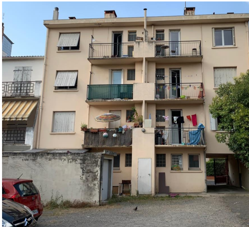
Avant (chaudières gaz individuelles)
