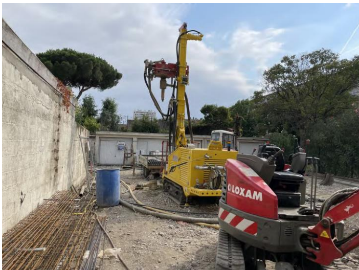
Réalisation forage F3
