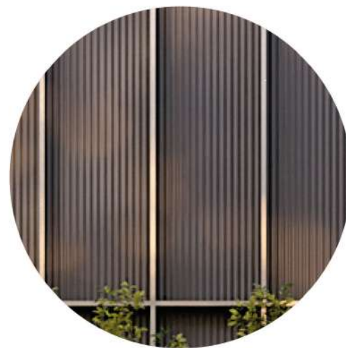
Bardage métallique type Fréquence + les lisses et les épines en aluminium
