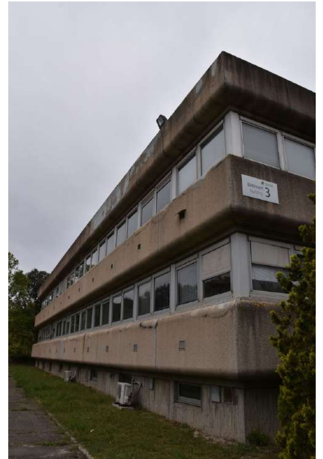
Bâtiment 3 – état existant
