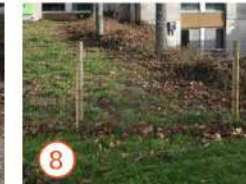
RÉEMPLOI CLÔTURE Poteaux et treillis pour la plupart (environ 400ml)
