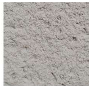
Murs extérieurs Enduits chaux isolants
