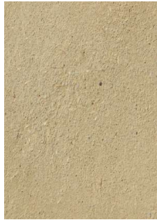
Enduit à la chaux
