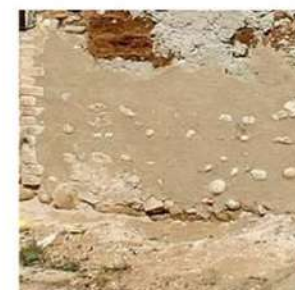
Enduits intérieurs Chaux pierre vue
