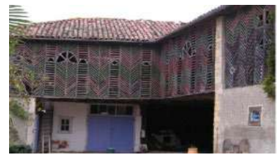
Langage de l'architecture locale Intégration dans son environnement
