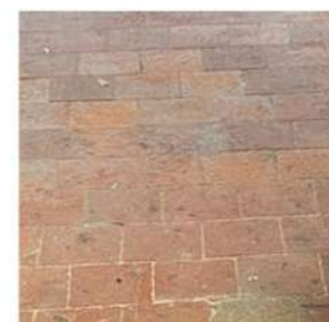
Sol en ré-emploi Tommettes terre cuite
