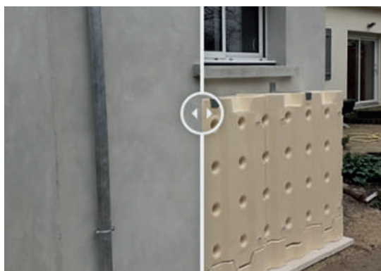
Maison individuelle équipée de collecteurs de 600 litres pièce installés en série Grenoble (38)
