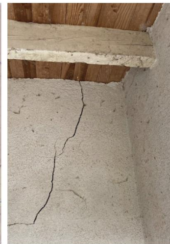
Fissures provoquées par les RGA
