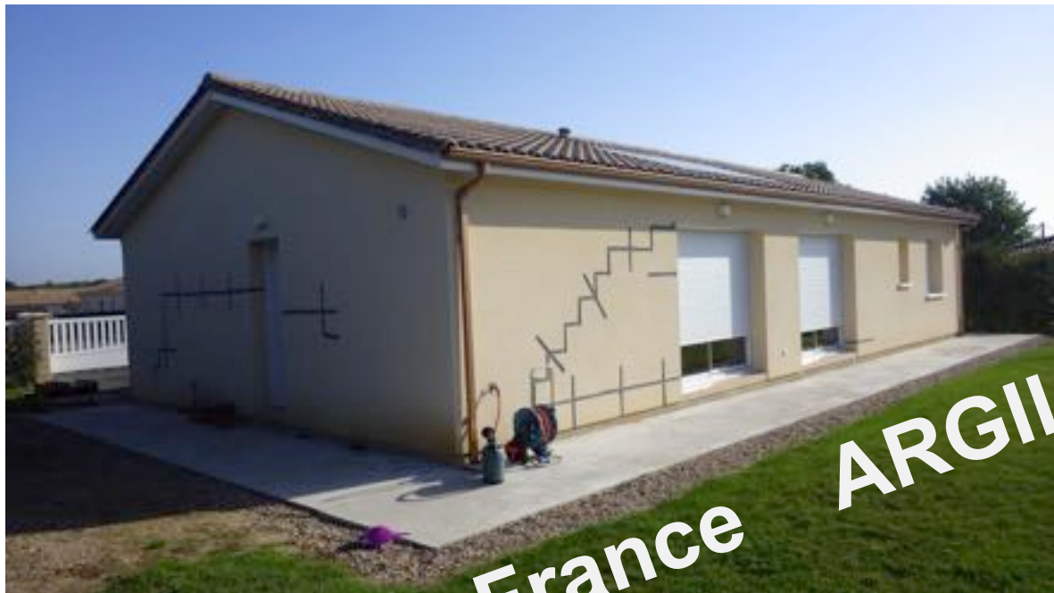
Maison instrumentée en 2016 après les MHCA Réparation des fissures en 2017
