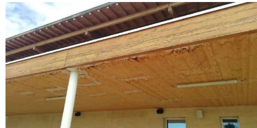
Traitement bois avec du vernis – Nécessite une reprise générale des éléments au bout de 2 ans
