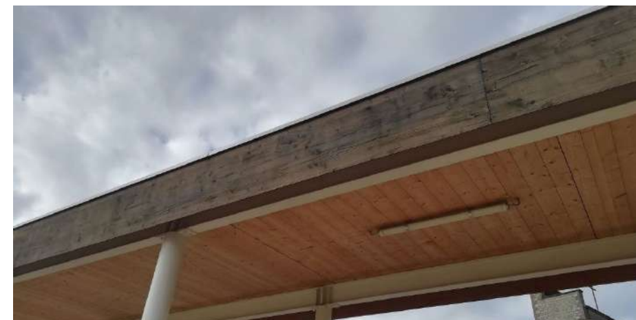
Sans traitement du bois – Effet du bois grisâtre mais ne nécessite pas de reprise des ouvrages
