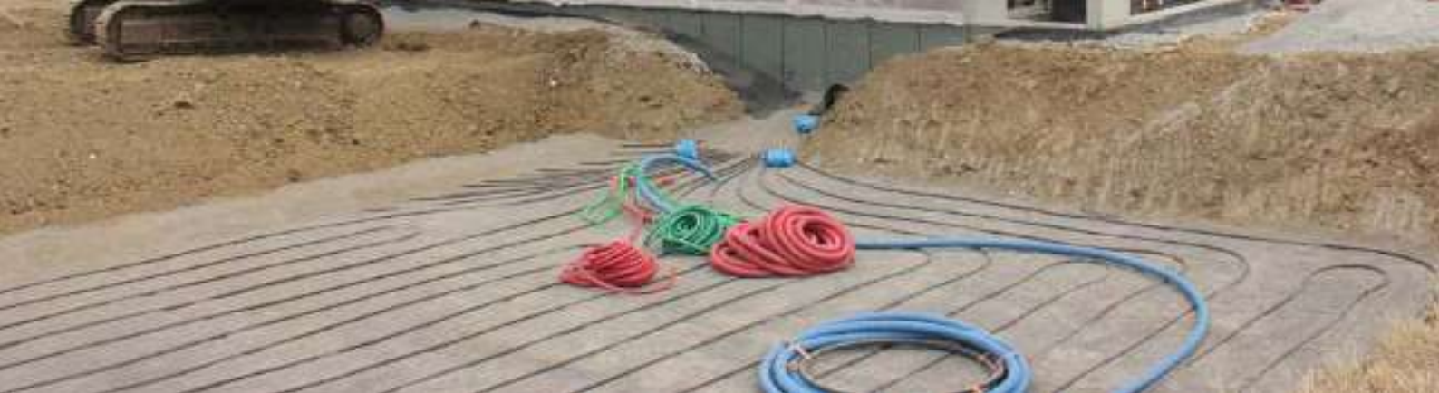
Puits climatique de la salle d'activités et des vestiaires à Monoblet (30) © Fabrice Perrin - Atelier Perrin François Seidel
