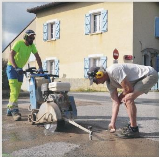
TRAÇAGE ET SCIAGE DES EMPRISES 14/04/25
