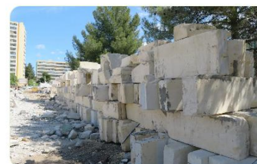
Dépose préservante de pierres naturelles de Castries de la résidence URANUS | Montpellier
