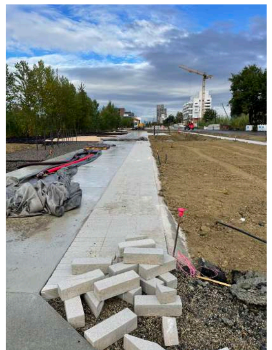
↓ Pose des pavés, secteur le forum, chantier en cours - Photo : Vizea
