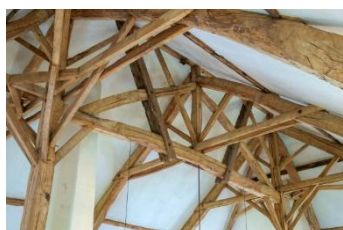
Charpente en bois massif généralement constituée d'essences locales
