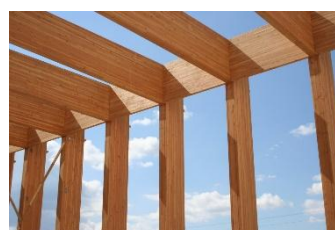
Charpente avec poutres de structure constituées de lamelles de bois collées entre elles
