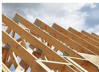
Charpente avec fermettes de bois assemblées en usine par des connecteurs en métal
