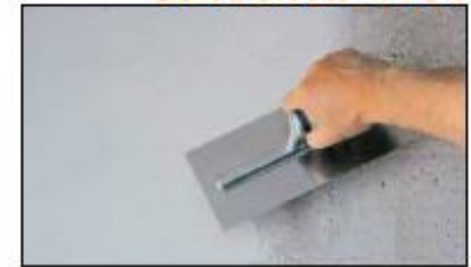
ENDUIT PLÂTRE SUR MUR EN BETON
