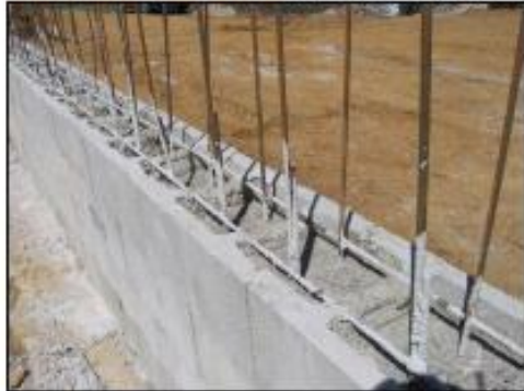
MUR DE REFEND BETON BANCHE
