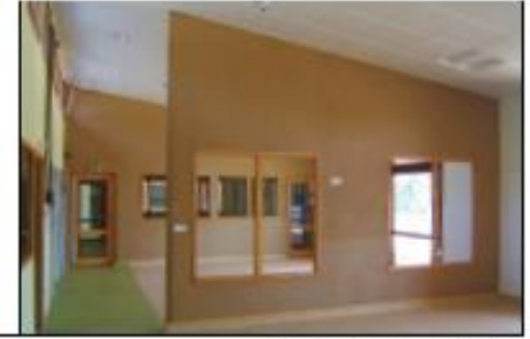
ENDUIT TERRE SUR MUR PAILLE
