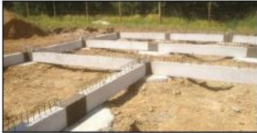
FONDATIONS: PRINCIPE LONGRINES SUR PUIITS
