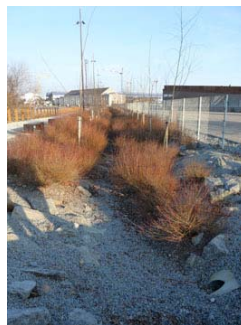
Tranchée d'infiltration
