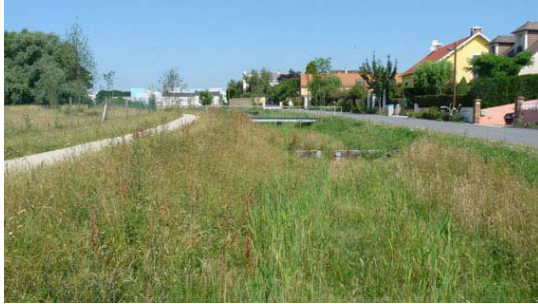
Bassin tampon régulé vers le ru des Gohards et positionné le long du chemin de la Sécherie
