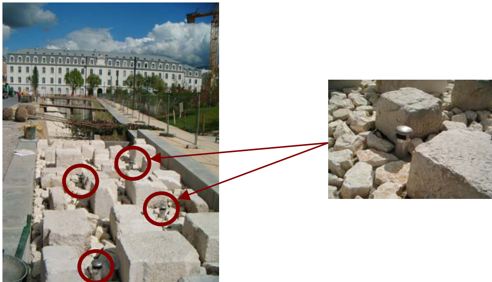
Arrivée de l'eau de la nappe dans le bassin par jets et ruissellement entre les rochers
