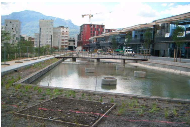
Bassin servant de récupération des eaux de pluie, d'agrément paysager, et de stockage d'eau d'arrosage
