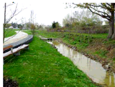
Ru des Gohards ouvert ZAC Bottière – Chénaie, Nantes
