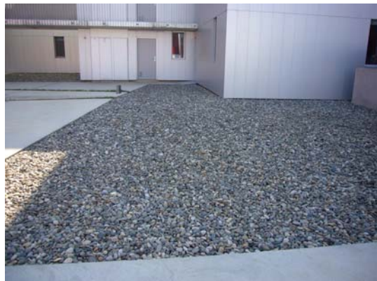
Détail de la structure en galets pour la récupération des EP avec collecte sous galets
