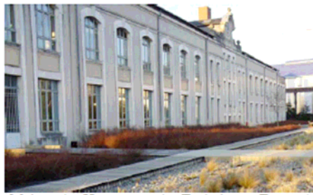
Maison des Hommes et des Techniques (Douves) Prairie au Duc, Nantes
