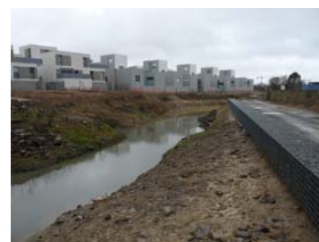
Futur marais épurateur
