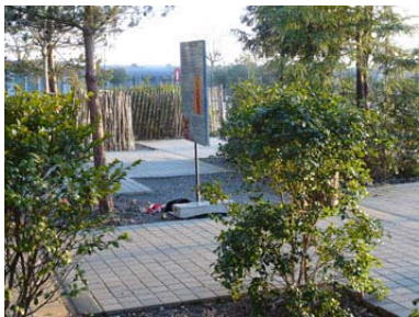
Aménagement perméable (pavage poreux)
