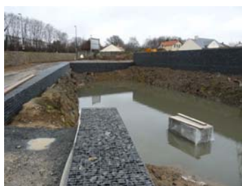
Début du ru des Gohards (bassins de pré-traitement en construction)
