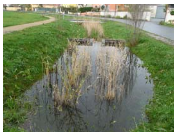
Bassin tampon dans le parc (rejet limité)
