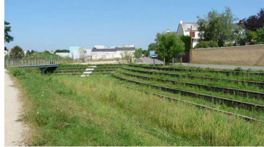
Bassin tampon régulé vers le ru des Gohards et positionné le long du chemin de la Sécherie
