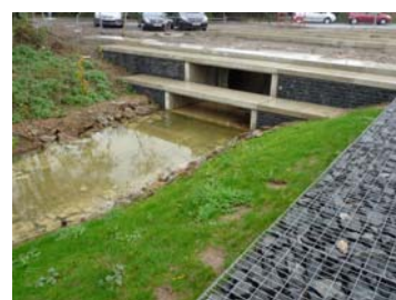
Exutoire du ru (raccordement à l'existant)
