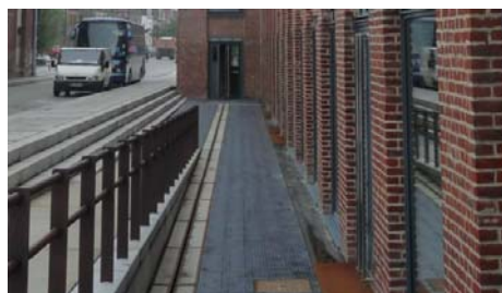
Bâtiment Leblan-Lafont (côté Av. de Bretagne)
