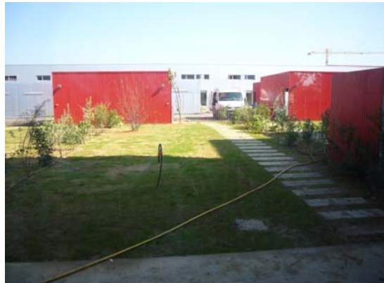
Parcelle en cours de végétalisation devant un T6 du Grand Patio
