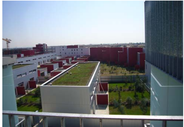
Vue sur une des toitures végétalisées du Grand Patio
