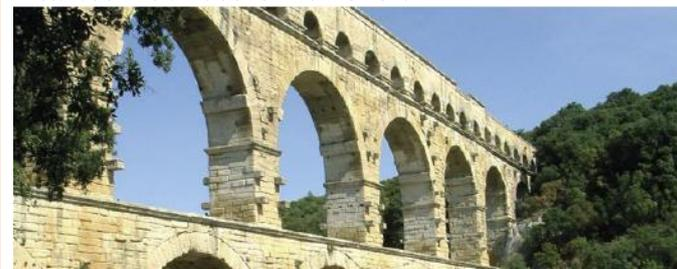
Sur le bâti, l'entretien de la pierre ne nécessite pas de produit chimique, il faut utiliser des solutions au Ph neutre spécifique à la pierre, à réaliser tous les 10 ans.
