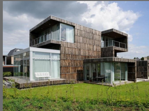
planches de bobines à câbles pour la villa Welpeloo aux Pays Bas Superuse Studio
