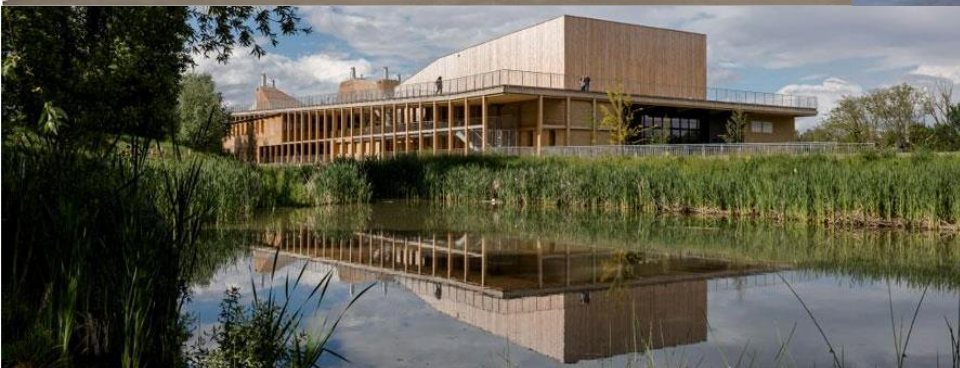
Pôle culturel à Corne- barrieu, architecte Philippe Madec
