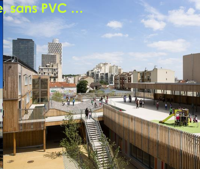
Ecole Stéphane Hessel à Montreuil, architecte: Méandre
