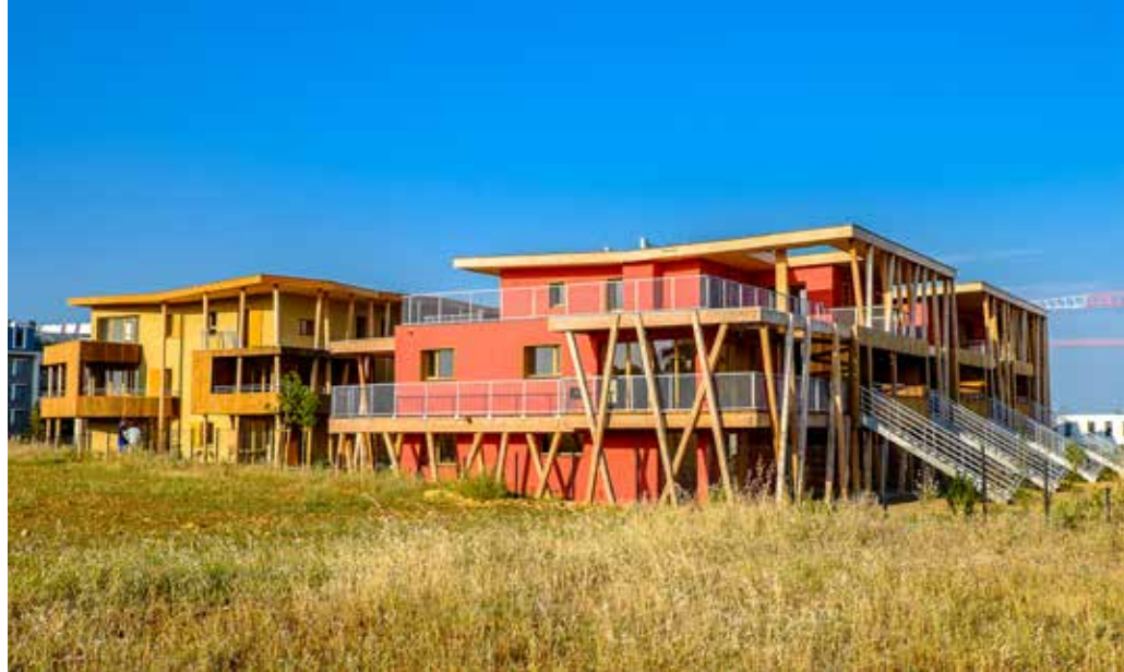
Façades ouest | © Frédéric JOZON
