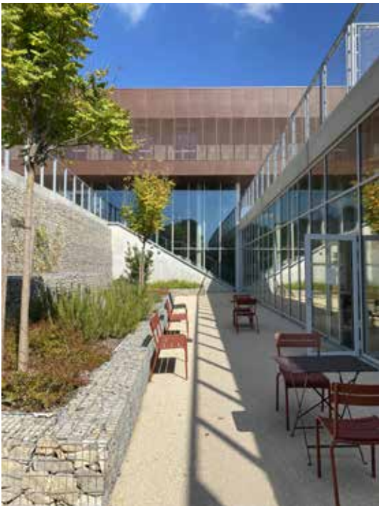
Vue sur la cour intérieure | © MDR Architectes
