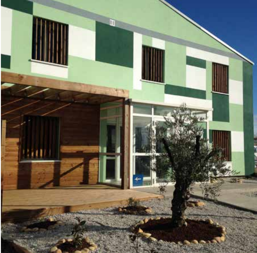
Façade ouest avec pergola et entrée principale | © Envirobot Occitanie
