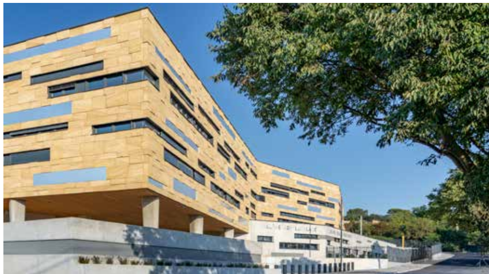
Façade est, entrée principale du collège | © Benoît WEHRLÉ
