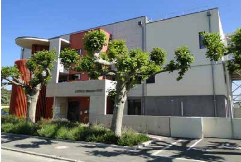
Façade sud et bloc ascenseur en saillie du bâtiment existant | © Envirobot Occitanie
