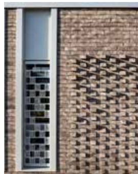
Détail façade, côté est | © KcomK Architectes
