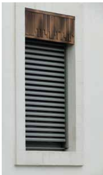
Détail de la façade, côté rue | © Envirobot Occitanie
