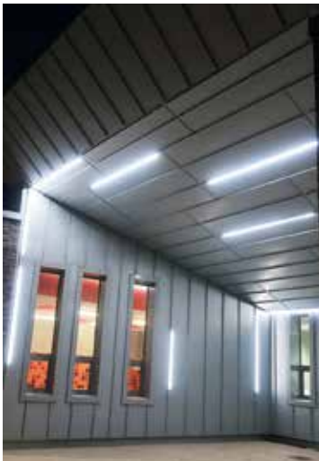
Détail menuiseries extérieurs | © KcomK Architectes
