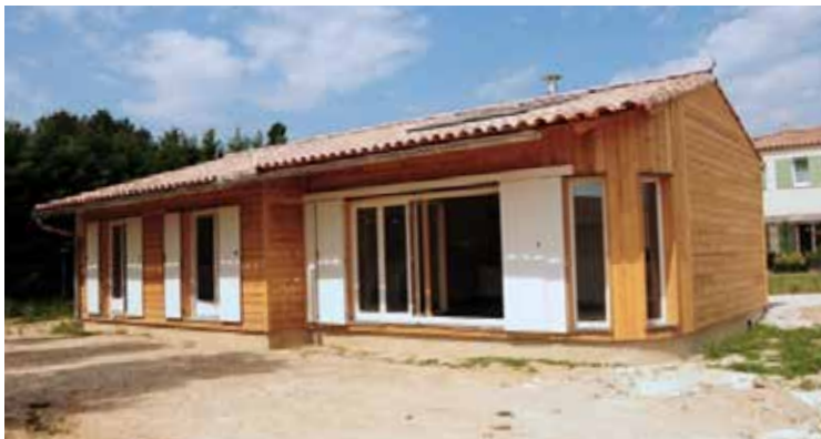
Vue extérieure façade avant | © Famille JEANNET - Les charpentiers d'Uzès - Bertrand OTTMER
