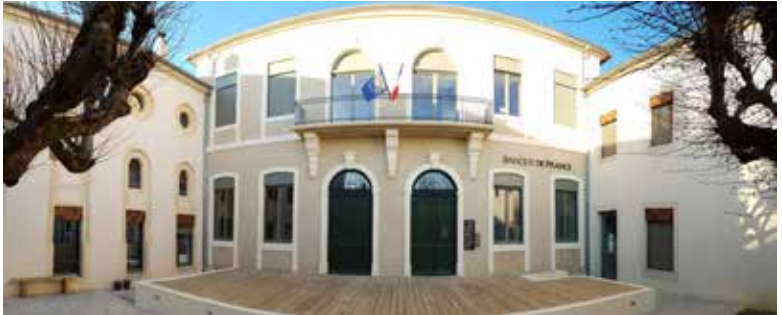
Façade sud, côté patio intérieur | © SCI Pierre Verte
