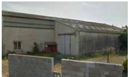
Façade sud avant rénovation | © Google
