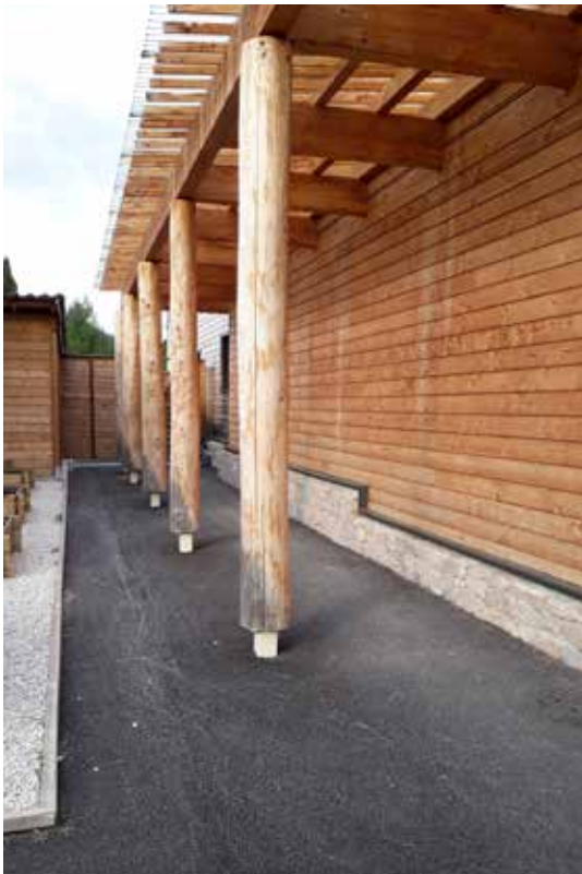
Détail espace abrité façade sud (cour) | © Envirobat Occitanie
