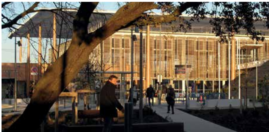
Façade sud-ouest (entrée principale) | © AREP / Anne BAUVY
