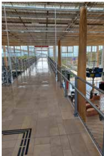
Accès aux quais | © Envirobot Occitanie
