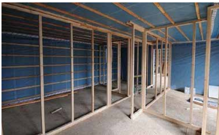
Vues du projet en phase chantier | © Famille JEANNET - Les charpentiers d'Uzès - Bertrand OTTMER
