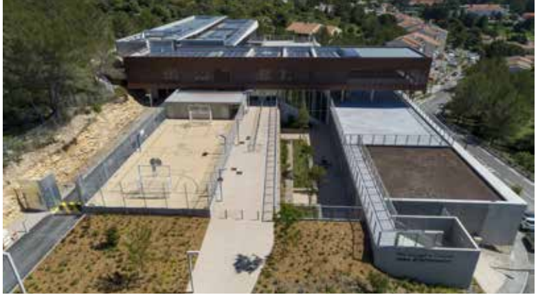
Vue aérienne du projet | © MDR Architectes
