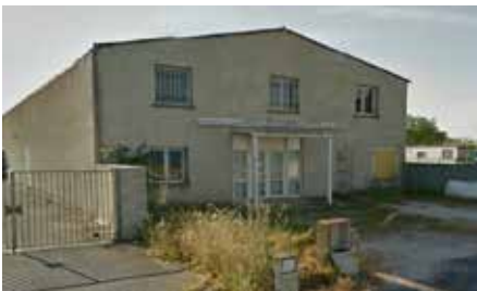
Façade ouest avant rénovation | © Google
