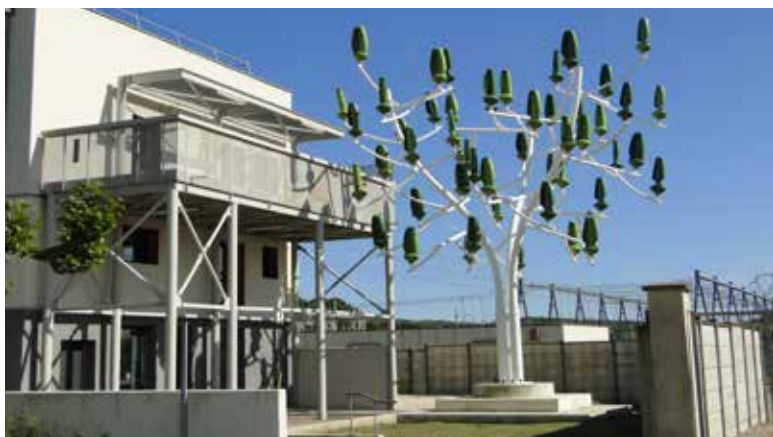
Façade est avec terrasses extérieures | © Envirobot Occitanie
