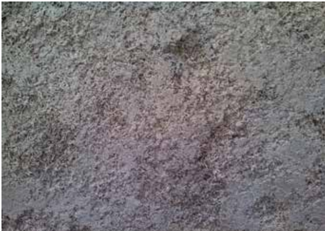
Détail mur en projection béton de chanvre | © Envirobat Occitanie
