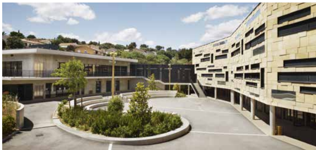
Vue extérieure sur la cour du collège | © Camille GHARBI
