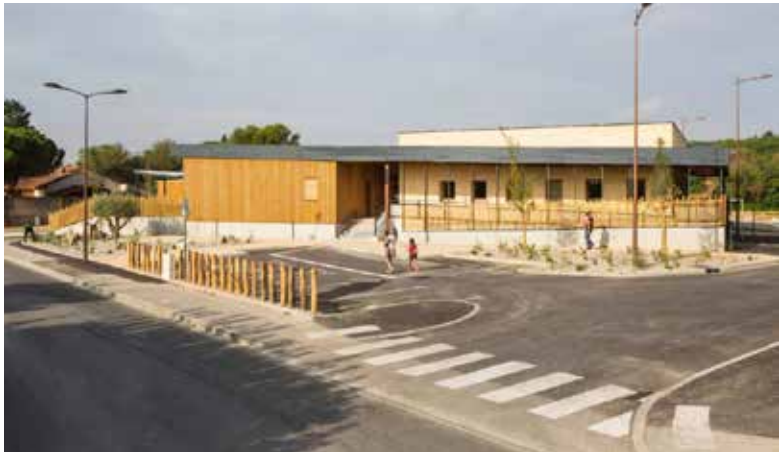
Façade est du bâtiment | © Atelier Inextenso
