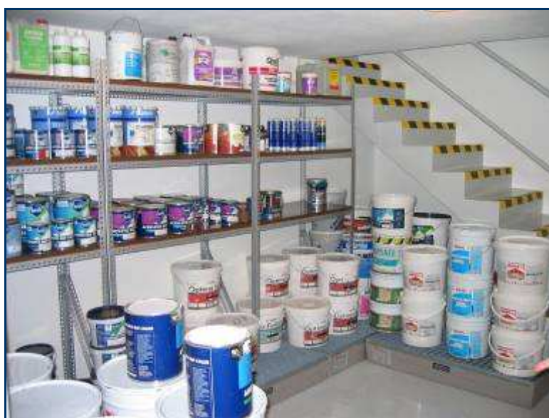
Exemples de bacs de rétention mis en place dans l'entreprise Peintures Schmitt (Sainte Croix en Plaine, Alsace)
