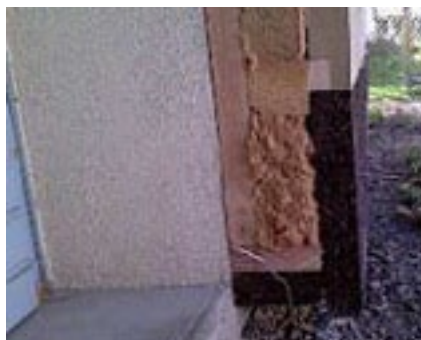
Photos du chantier d'Henri : isolation par l'extérieur avec 19 cm de fibre de bois
