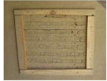
Fenêtre témoin : on y voit le coffrage perdu en baguette des murs copeaux-terre
