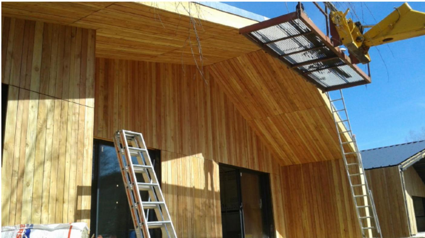
Pose des bacs de couverture en acier sur les caissons en bois isolés et chevrons.
