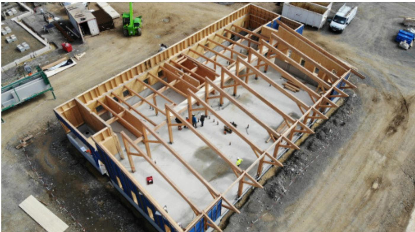
Vue aérienne prise au drone. On peut observer la structure bois de la crèche en cours de chantier. - Photo : APACHE architectes
