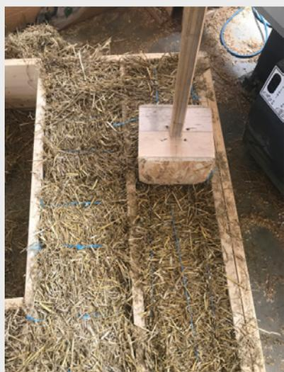
Remplissage paille d'un caisson bois en atelier. - Photo : APACHE architectes
