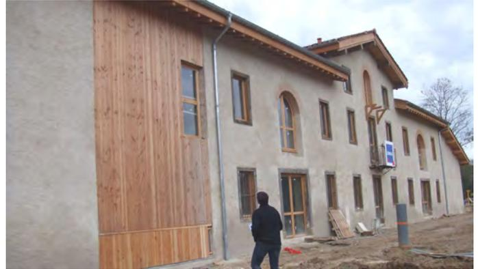
Vue de la façade Nord pendant les travaux (octobre 09) : les enduits extérieurs ont été refaits à la chaux, les portes et fenêtres ont été refaites en bois, le mur de la grange à gauche de la photo a été reconstruit en ossature bois, isolé en panneaux de fibres de bois et bardé à l'extérieur en Pin Douglas non traité qui va griser naturellement avec le temps.
