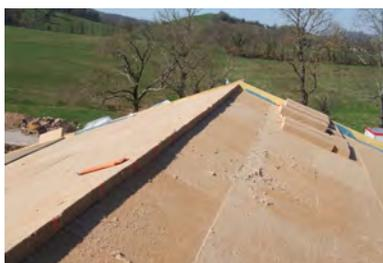
Panneaux isolants en fibres de bois mis en place sur la toiture (photo mars 2009)
