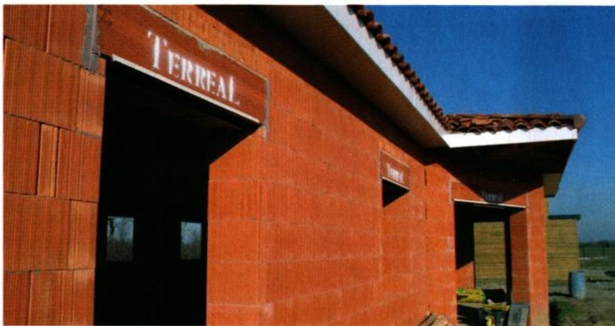
La maison individuelle construite à Colomiers avec le système à isolation répartie Calibric monomur de Terreal, a reçu le label BBC. Le matériau offre de bonnes performances de résistance et d'inertie thermique, ainsi qu'une bonne tenue dans le temps. / A single-family home in Colomiers built with the Calibric mono-wall distributed-insulation method, developed by Terreal, which received the BBC label. The material complies with standards for strength, thermal inertia, longevity.
