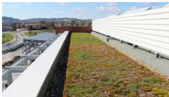
5 ème façade : toiture végétalisée et brise-vue masquant les équipements techniques - Photo © CAUE 81
