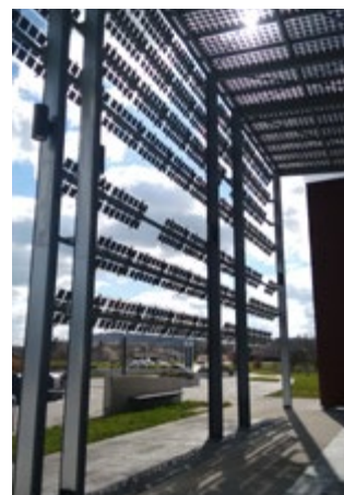
← Espace restauration donnant sur le parvis protégé par des brise-soleil photovoltaïques accrochés à une structure secondaire → Photo © CeRCAD
