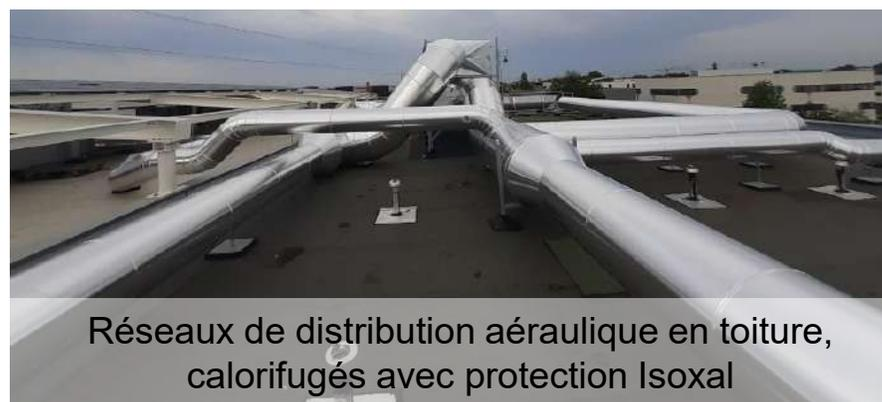
Réseaux de distribution aéraulique en toiture,
