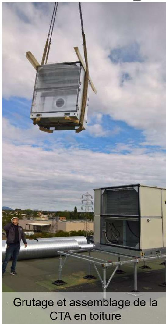
Grutage et assemblage de la CTA en toiture
