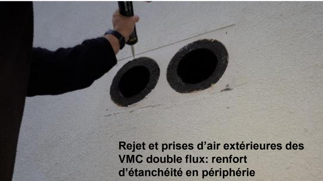
**Rejet et prises d'air extérieures des VMC double flux: renfort d'étanchéité en périphérie**
