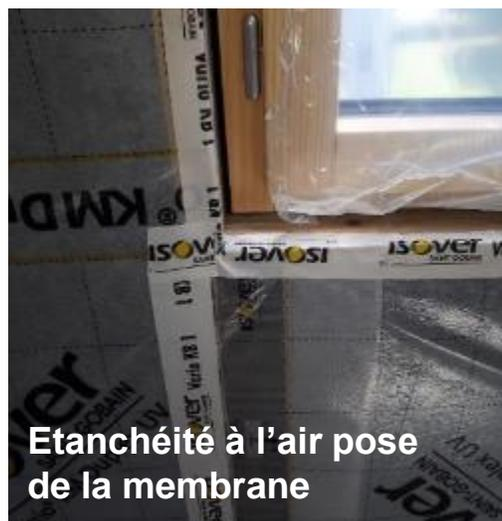
**Etanchéité à l'air pose de la membrane**
