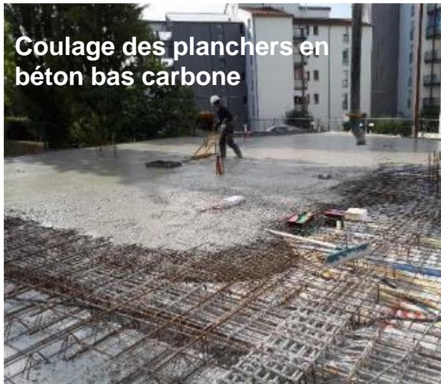
Coulage des planchers en béton bas carbone
