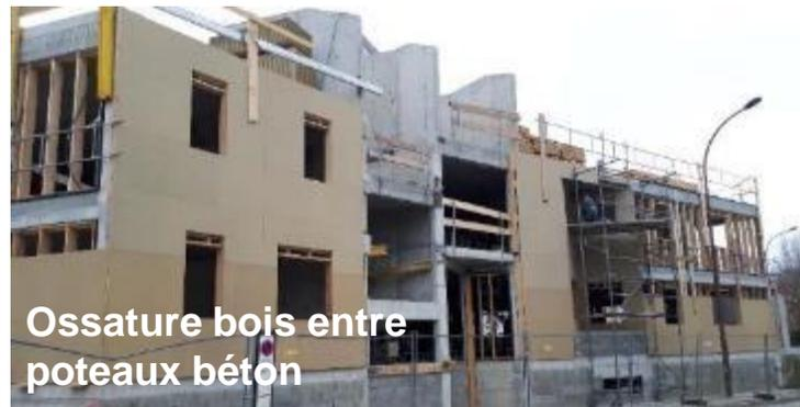
Ossature bois entre poteaux béton
