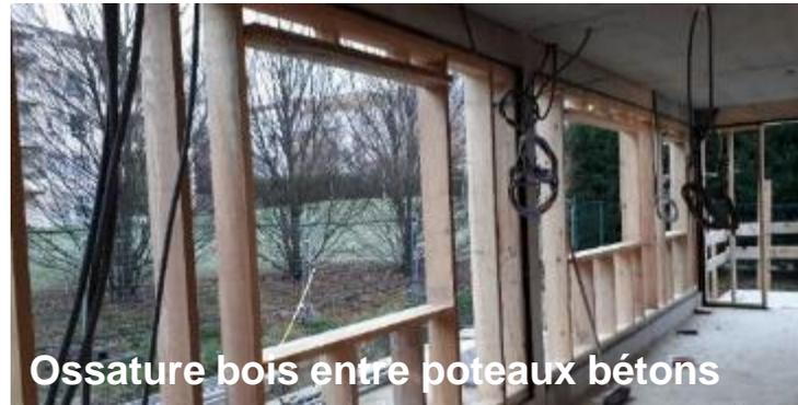
Ossature bois entre poteaux bétons
