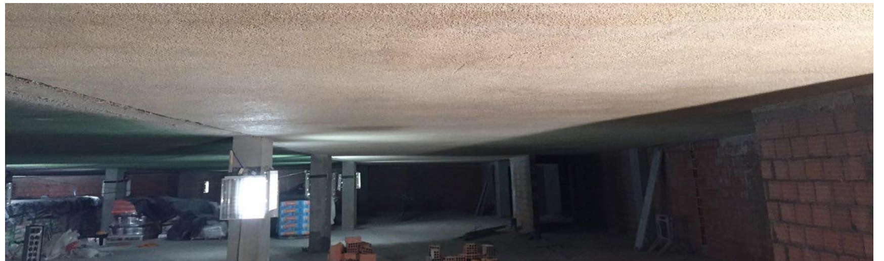
“Terminal Croisières - Porto de Lisbonne”, Portugal, 2016-2017
