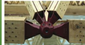
Les connecteurs métalliques permettent des assemblages précis
