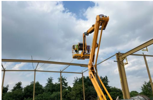
Dépose soignée de la charpente
