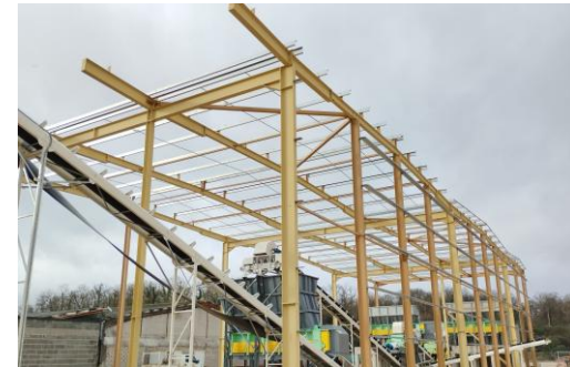
Remise en œuvre d'une partie du bâtiment 8
