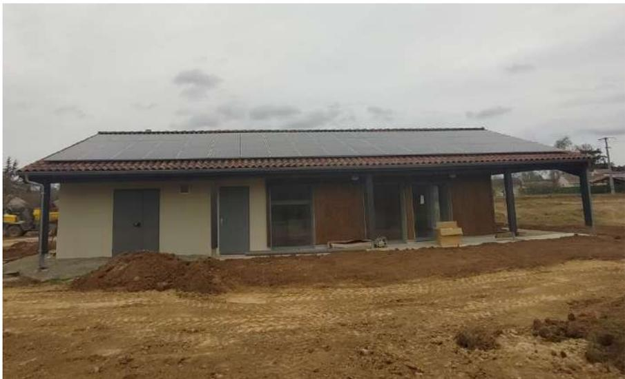
Installation de 54 modules PV Sunpower Maweon 3 – 21,6 kWc :
