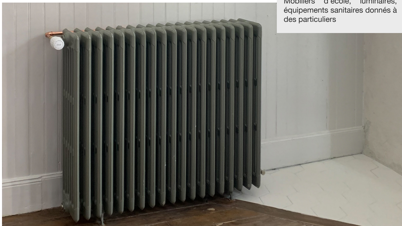
Radiateur en fonte réemployé après sa remise en état. Le parquet existant a été revitrifié. - Photo : Envirobot Occitanie
