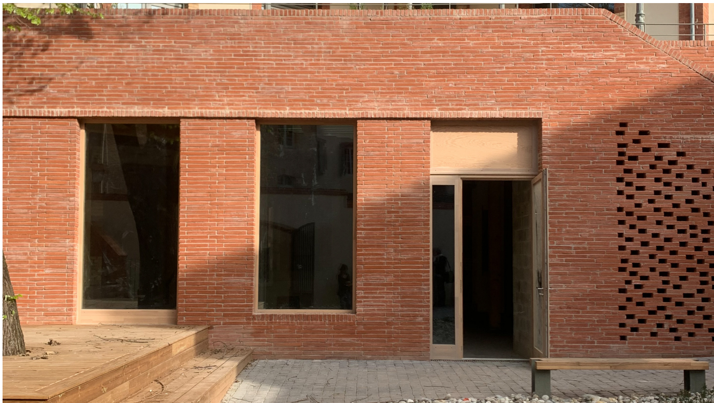
Façade donnant sur l'intérieur de l'ilot. À droite, le moucharabieh du local technique non isolé permet l'installation d'une climatisation pour les commerces (en mesure conservatoire). L'enjeu est qu'elle ne soit pas installée. - Photo : Envirobot Occitanie
