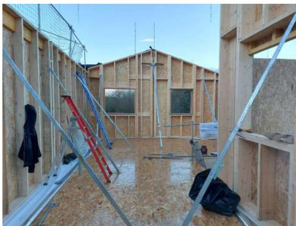
Ossature bois avant remplissage isolant
