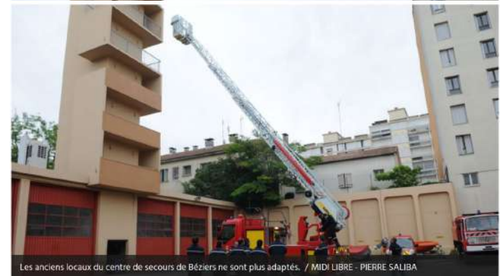
Les anciens locaux du centre de secours de Béziers ne sont plus adaptés. / MIDI LIBRE - PIERRE SALIBA
