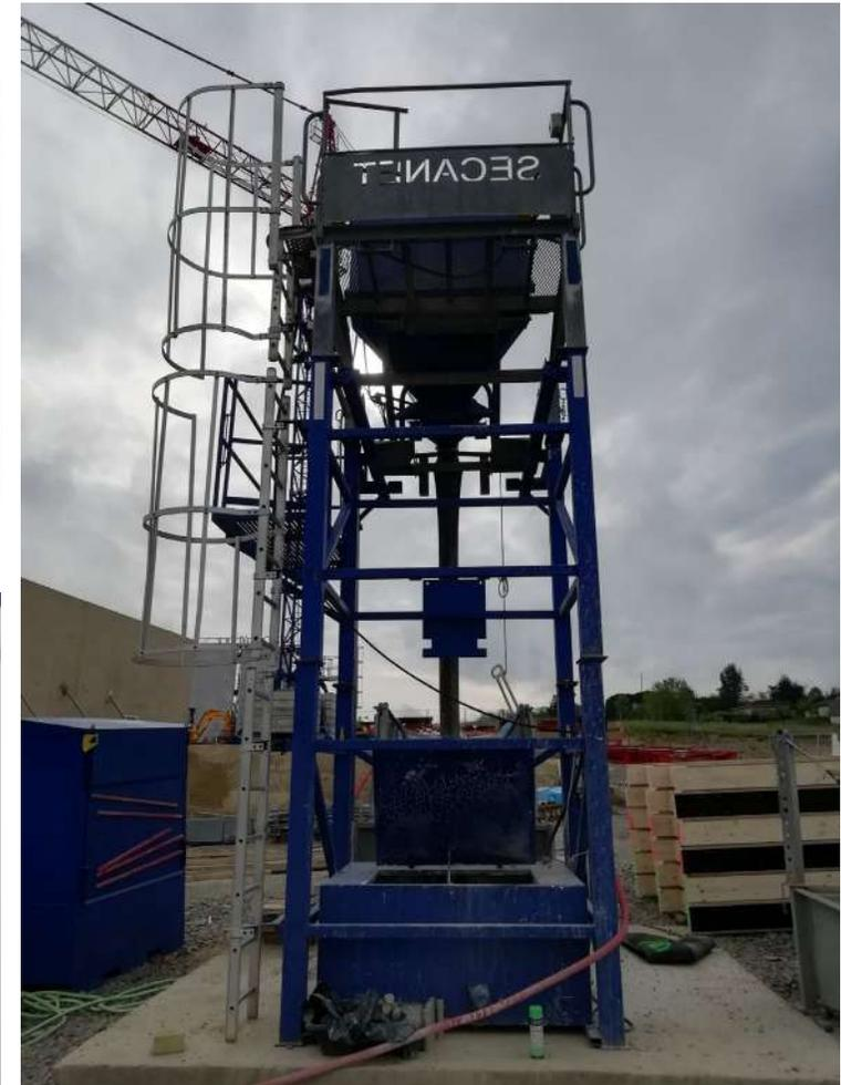
Plateforme de lavage des bennes béton
