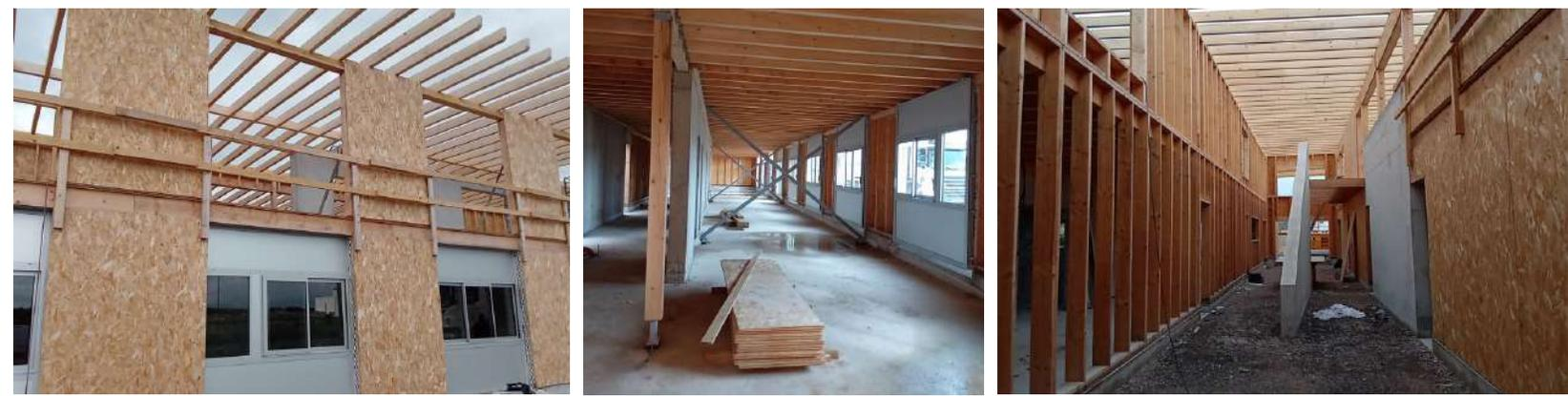
L'ensemble de l'ossature bois se réalise, les contreventements sont posés, la structure générale prend forme.
