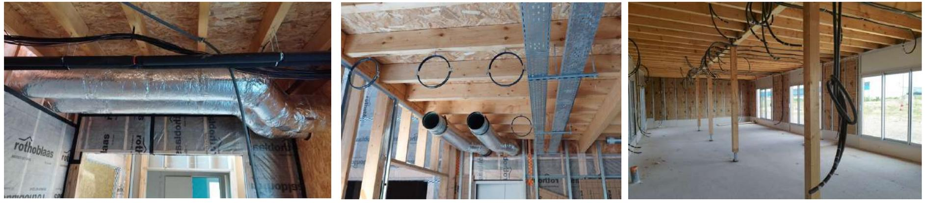
Les passages de réseaux en faux plafonds doivent être réalisés avec précision, les hauteurs disponibles sont limitées et l'encombrement important, avec des réseaux électriques et données retenus apparents à l'étage. L'aménagement de la chaufferie et des équipements CVC se réalisent dans le même temps.
