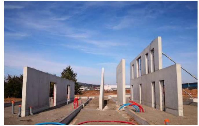
Les élévations en béton sont rapidement réalisées. Les travaux de VRD permettent de placer les réseaux, de raccorder l'eau de ville et le réseau BRL, et de mettre en place les éléments enterrés du puits climatique
