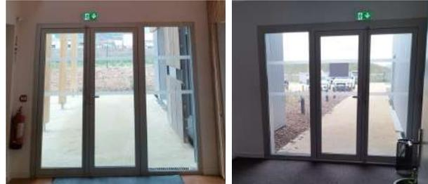
Cadre aluminium avec rupteurs de ponts thermiques
