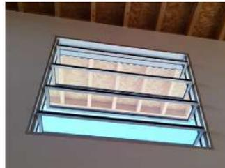
Désenfumage et Aération - Châssis support Acier
