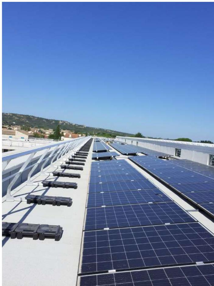
Photovoltaïque en toiture : 99kWc, dont 67,3 kWc en autoconsommation et 31,7kWc en revente totale (étude d'optimisation économique par Plus de Vert)
