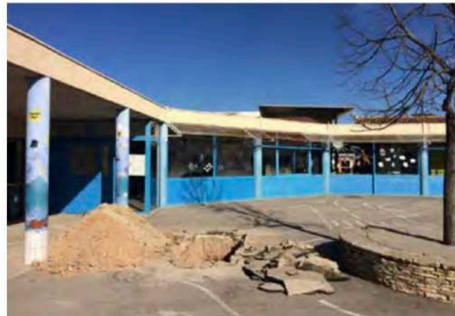
Sondages pédologiques dans les différentes cours
