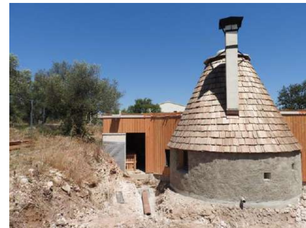
Murs courbe en chanvre de la Kasanou
