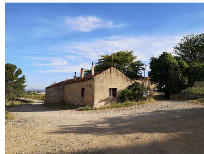
Entrée coté cour agricole
