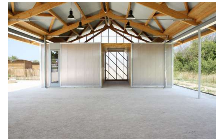
Halle des jardins familiaux à Uzès Structure bois et isolation bio-sourcée KOMBO ARCHITECTES
