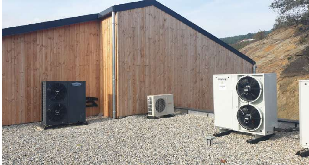
Toiture : unités extérieures PAC process et local commun
