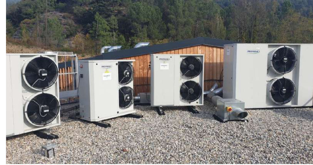
Toiture : unités extérieures PAC process et local commun
