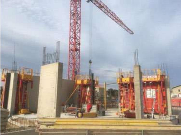
Elévations en béton banché
